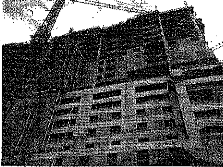
建築中のコンドミニウム
